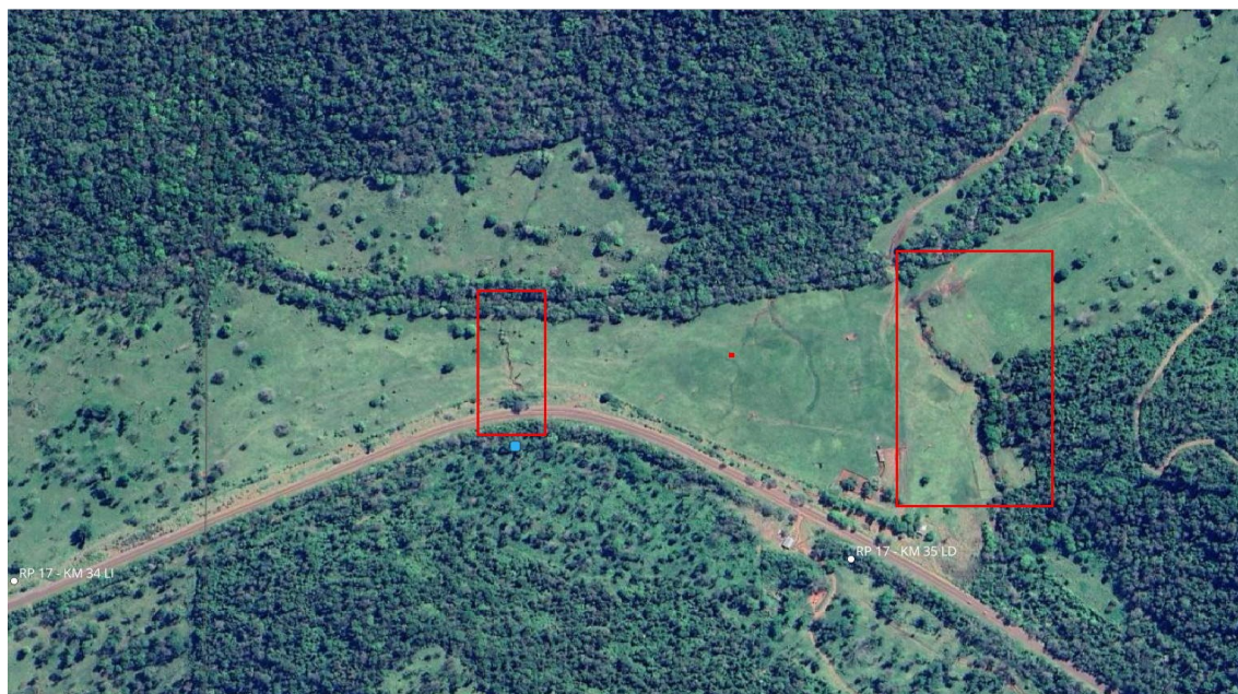
Fotografía 7. Ejemplo de dos localizaciones de cauces de pequeños arroyos “conectores” carentes de vegetación riparia y asociados a alcantarillas de drenaje adaptadas para paso de fauna en Hábitats Críticos de la RP17. Imagen satelital de Estancia La Emilia, Santiago de Liniers, Provincia de Misiones.
